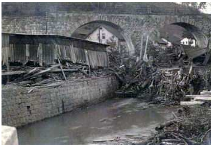
Viadukt v Desné po katastrofě.
