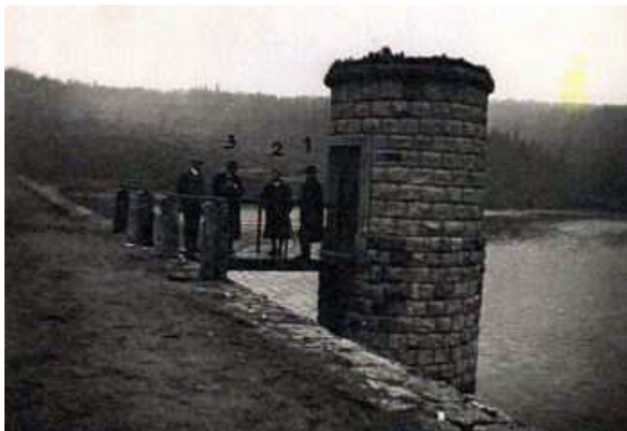
Inspekce hráze přehrady.
